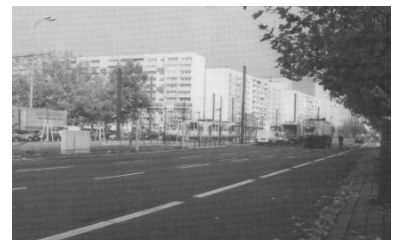
Eine alltägliche Situation an der Haltestelle: Die Gitter tragen eher dazu bei, daß das Überqueren gefährlich wird. (Foto: Frank Böhnke, November 1999)
