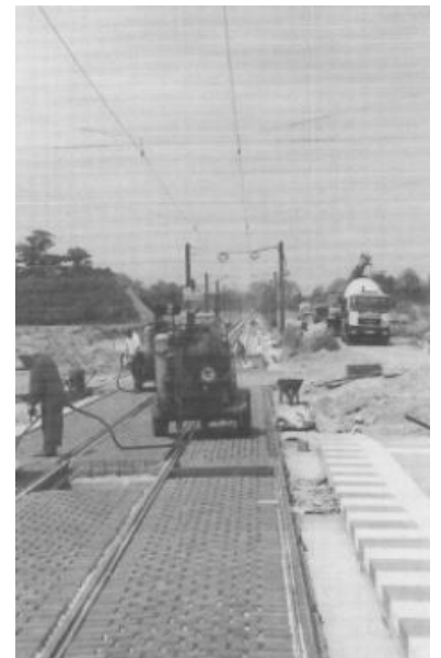
Die neue Straßenbahn-Trasse in das Bornstedter Feld. So sollte es eigentlich überall sein: Die öffentlichen Verkehrsmittel werden mit in die Bauplanungen von Anfang an integriert. (Foto: Frank Böhnke, Juli 1999)
