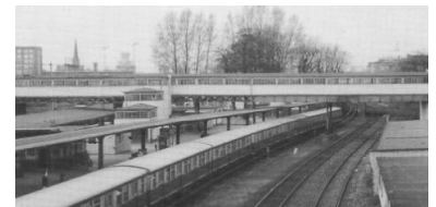
Der Stadtbahnsteig mit der Fußgänger-Verbindungsbrücke. (Foto: Marc Heller)
