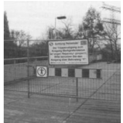
S-Bahnhof Ostkreuz: der mittlerweile wegen baulicher Mängel gesperrte Zugang zum Marktgrafendamm. (Foto: Frank Böhnke)
