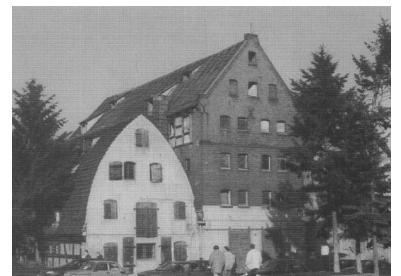
Am Ufer der Brda in Bydgoszcz im alten Hafen stehen diese historischen Speichergebäude. (Foto: Frank Lammers)
