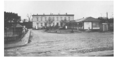
Bahnhof Glöwen mit seiner Fehlinvestition: Der Bahnsteigtunnel (im Bild rechts) nicht erforderlich, da der Bahnhof zwei Seitenbahnsteige hat, die von der Straße her zugänglich sind. Nur ein Bahnsteig besitzt eine Rampe für Rollstuhlfahrer, die zweite Bahnsteigrampe fehlt. Der Tunnel liegt im Bereich der ehemaligen Wendeschleife. Eine Schleifenfahrt für Busse zur Bedienung der Haltestelle ist nicht mehr möglich. (Foto: Matthias Hansen, März 1999)
