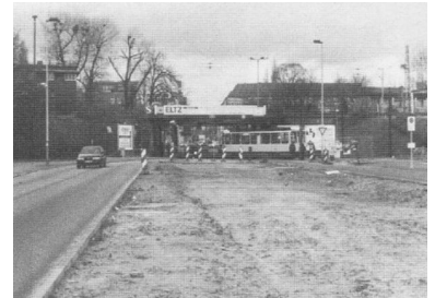
Beim Ausbau der Rudower Straße wurde der Mittelstreifen in für die Straßenbahn ausreichender Breite angelegt. (Foto: Alexander Frenzel, Dezember 1999)
