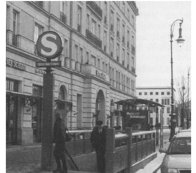
Am Bahnhof Unter den Linden soll ein Umsteigebahnhof entstehen. (Foto: Alexander Frenzel, Januar 2000)
