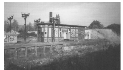
Abriß des alten S-Bahnsteiges Papestraße im Dezember 1999. Hier soll ein wichtiger Umsteigebahnhof zwischen der S-Bahn, dem Regional- und Fernverkehr entstehen. Die Deutsche Bahn AG überlegt derzeit, auf den Bau des Fernbahn-Haltes zu verzichten. (Foto: Frank Böhnke)
