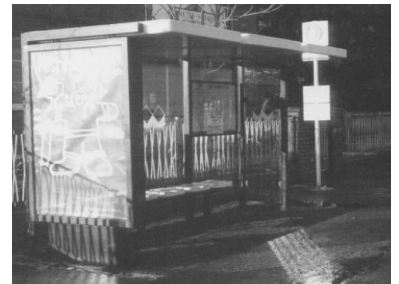
An der Haltestelle Lübbenauer Weg (Straßenbahn-Linie 68) steht dieses neue Warthäuschen. Die Baufirma hatte es mit der Fertigstellung nicht sehr eilig, den der Gehwegbelag um das Häuschen herum fehlt. Wenn es regnet, sammelt sich das Wasser ausgerechnet dort, wo das Häuschen Schutz bieten soll. Schilda läßt grüßen! (Foto: Alexander Frenzel, Dezember 1999)
