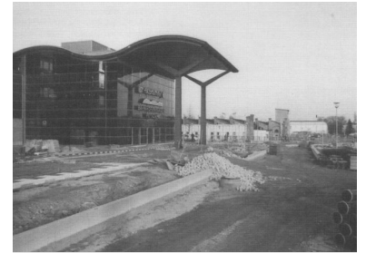
Potsdam Hauptbahnhof Süd: Anfang März noch eine einzige Baustelle, sollen hier bereits Mitte April Straßenbahnen und Busse fahren. (Foto: Marc Heller, März 2000)
