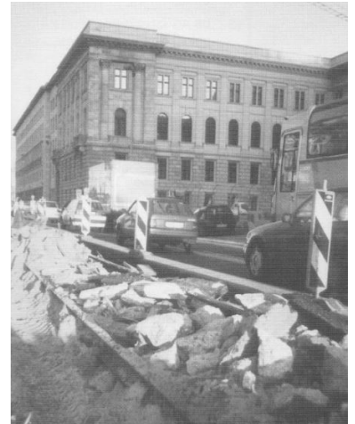
Archäologie in Berlin: Bei den Vorbereitungen zum Einbau der Straßenbahn-Gleise in die Leipziger Straße sind die alten untern Fahrbahnbelag wieder aufgetaucht. Vielleicht werden uns unsere Nachfahren mal fragen, warum die Straßenbahn in der Leipziger überhaupt stillgelegt wurde... (Foto: Alexander Frenzel, April 2000)
