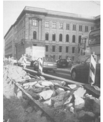
Archäologie in Berlin: Bei den Vorbereitungen zum Einbau der Straßenbahn-Gleise in die Leipziger Straße sind die alten untern Fahrbahnbelag wieder aufgetaucht. Vielleicht werden uns unsere Nachfahren mal fragen, warum die Straßenbahn in der Leipziger überhaupt stillgelegt wurde... (Foto: Alexander Frenzel, April 2000)
