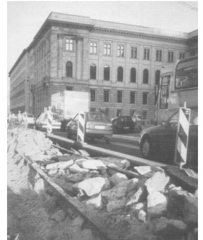
Archäologie in Berlin: Bei den Vorbereitungen zum Einbau der Straßenbahn-Gleise in die Leipziger Straße sind die alten untern Fahrbahnbelag wieder aufgetaucht. Vielleicht werden uns unsere Nachfahren mal fragen, warum die Straßenbahn in der Leipziger überhaupt stillgelegt wurde... (Foto: Alexander Frenzel, April 2000)
