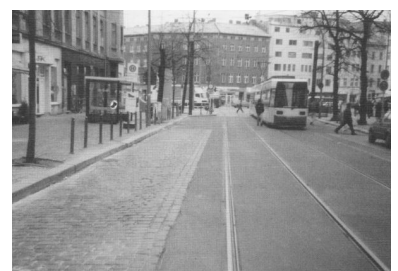
Durch Bauarbeiten bedingt sind die Haltestellen der Straßenbahnlinien 13 und 53 U-Bahnhof Rosenthaler Platz im Weinbergsweg unmittelbar zum U-Bf. gerückt worden - mit mobiler Warthalle. Dieser Haltestellenstandort sollte zum Dauerzustand werden, 50 Meter Umsteigeweg müssen an dieser Stelle nicht sein.
