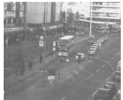
Ein Rudiment des alten Berliner Straßenbahn-Netzes ist auf den Walter-Schreiber-Platz in Steglitz zu sehen: die Fußgängerinseln der ehemaligen Straßenbahn-Haltestellen, die heute von Bussen und Taxen benutzt werden. Nun plant das Bezirksamt Steglitz, den Platz zu verschönern. Da leider immer noch kein gültiger Gesamtplan über die Weiterentwicklung der Straßenbahn in Berlin vorliegt (was hat der Senat eigentlich im letzten Jahrzehnt gemacht?), werden hier möglicherweise wichtige wieder zu nutzende Flächen bebaut. Denn das es sich lohnt, den 148er durch eine entsprechende Straßenbahn-Linie zu ersetzen, steht außer Frage. (Foto: Martin Schiefelbusch, März 2000)
