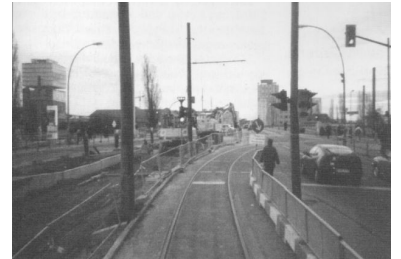
Der Einbau der Straßenbahngleise für die Linie 20 über die Warschauer Brücke zum U-Bahnhof Warschauer Straße macht Fortschritte. Auf den Weiterbau über die Oberbaumbrücke Richtung Hermanplatz werden wir aber noch warten müssen... (Foto: Frank Brunner, März 2000)
