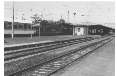
Können internationale Verbindungen - wie hier IR 316 (Berlin - Malmö) bei der Einfahrt in Eberswalde Hbf - wirklich nur mit finanziellen Verlusten aufrechterhalten werden? Nicht überzeugen können hier entsprechende Aussagen der DB AG. Wie vertragen sich die in den letzten Jahren in diesem Bereich vorgenommenen Einschränkungen eigentlich mit dem Sinn eines Dienstleistungsunternehmens? (Foto: Christian Schulz, Mai 2000)
