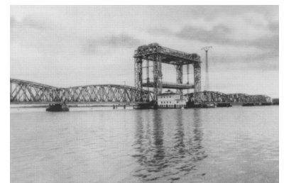
Die Eisenbahn-Hubbrücke bei Karmin 1935. (Sammlung: Hans Nadler, Leipzig)
