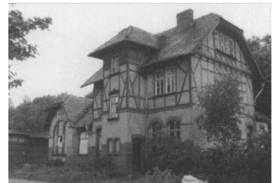
Bahnhof Karnin. Bahnhofsgebäude Karnin, zwei Wochen vor Beginn der Rekonstruktion 1998. (Foto: Sammlung Joachim Evers)
