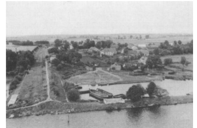
Blick auf Karnin, ca 1955. In diesem Zustand dämmerte das Areal bis 1998 dahin. Das Bahnhofsgebäude ist zwischen den Bäumen am Bahndamm erkennbar. (Foto: Reimann, Sammlung Ausstellungs- und Informationscenter Hist.)
