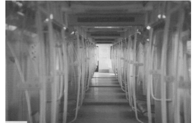
Innenansicht des H-Zuges. (Foto: Marc Heller)
