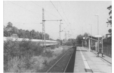
Am Bahnhof Griebnitzsee mündet die Stammbahn in die bestehende Strecke nach Potsdam (links im Bild). (Foto: Frank Böhnke, September 1999)
