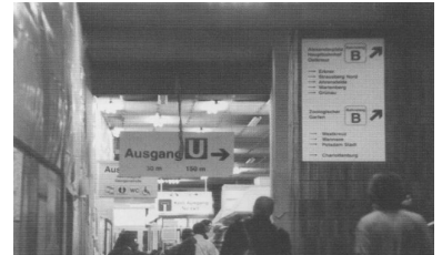
Bahnhof Friedrichstraße während des Umbaus im September 1995. Heller und freundlicher ist es hier heute. Die Ausschilderung und Fahrgastinformation läßt dennoch leider immer noch zu wünschen übrig. (Foto: Marc Heller)
