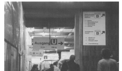
Bahnhof Friedrichstraße während des Umbaus im September 1995. Heller und freundlicher ist es hier heute. Die Ausschilderung und Fahrgastinformation läßt dennoch leider immer noch zu wünschen übrig. (Foto: Marc Heller)
