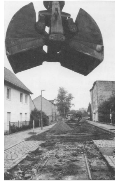
... das soll jedenfalls nach dem Entwurf zum StEP Verkehr nicht die Zukunft der Straßenbahn in Berlin sein! (Abbau von Gleisen in Altglienicke) (Foto: Irmgard Schmidt)
