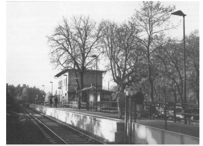
Der neue Bahnsteig am Bahnhof Wandlitz. Am linken Bildrand die Reste des zweiten Gleises. (Foto: Sven Jagdhun, 23. Oktober 2000)
