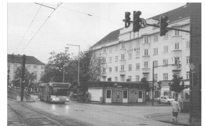
Vorbild Hannover? An der Haltestelle Vier Grenzen wurde vor einigen Jahren ein Tür an Tür Übergang vom Bus zur Stadtbahn stadteinwärts geschaffen. Die Bahntrasse liegt in der Mitte einer Hauptverkehrsstraße, folglich liegt die Bushaltestelle entgegen der Fahrtrichtung der Bahn wie auch des Autoverkehrs. Der Haltestellenbereich ist deutlich abmarkiert und kann vom einfahrenden Bus direkt aus einer Seitenstraße angefahren werden. Bei der Ausfahrt jedoch muß er nach dem Verlassen der Anlage für einige Meter die Autofahrspuren entgegen deren Richtung benutzen (quasi als Geisterfahrer), bevor er wieder abbiegen kann! Damit alles seine Ordnung hat, ist dieser Fahrweg natürlich durch eine eigene Ampelphase gesichert, so daß dem Bus nichts in die Quere kommen kann. (Foto: Martin Schiefelbusch, November 2000)
