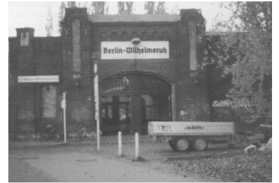
Der wiedereröffnete Zugang. (Foto: Alexander Frenzel, November 2000)
