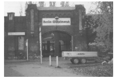
Der wiedereröffnete Zugang. (Foto: Alexander Frenzel, November 2000)
