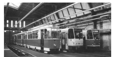
Die Erneuerung des Berliner
