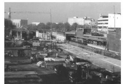
Stichwort S-Bahn-Ringschluß: Auch dieser Termin rückt immer weiter nach hinten. Der jetzt genannte Termin 2003 wird sicherlich nicht der letzte sein. (Foto: Frank Böhnke, November 1999)
