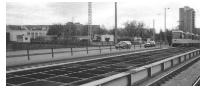
... statt Gitter soll hier eine Treppe den Fußweg zum S-Bahnhof verkürzen. (Foto: Alexander Frenzel, Februar 2001)
