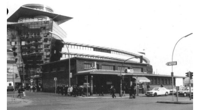
Empfangsgebäude des U-Bahnhofs Gesundbrunnen aus dem Jahre 1930 (im Vordergrund). Die Abrißwünsche der BVV Mitte dokumentieren in erschreckender Weise den hilf- und geschichtslosen Umgang der Bezirkspolitik mit Bauwerken. (Foto: Alexander Frenzel, Februar 2001)
