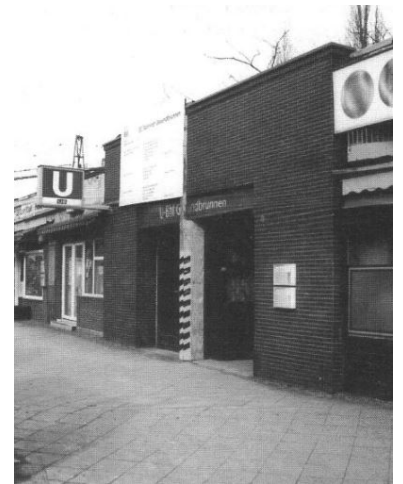
Bereits sanierter östlicher Zugang zum U-Bahnhof. (Foto: Alexander Frenzel, Februar 2001)
