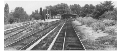
S-Bahnhof Ostkreuz: Erst wenn die Sanierung kommt, kommt auch der Aufzug. Ob das wirklich zwischen 2004 und 2006 passieren wird? (Foto: Alexander Frenzel)
