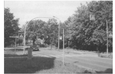
An dieser Stelle der Mahlower Straße (Nähe Wilhelm-Leuschner-Str.) soll 2004 der S-Bahnhof Teltow Stadt die Straße unterqueren. (Foto: Florian Müller, September 2000)
