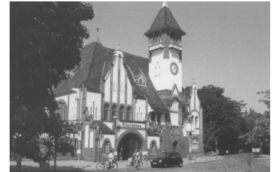
S-Bahnhof Nikolassee: Für den Aufzugseinbau gibt es noch keinen Termin. (Foto: Alexander Frenzel, August 2001)
