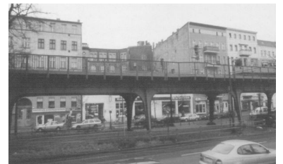
Hochbahn-Viadukt am U-Bahnhof Bülowstraße: Bei der Sanierung 1995/1996 wurden die alten Brückenteile verschrottet. Der Denkmalschutz kam zu spät. (Foto: Alexander Frenzel)
