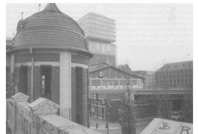
U-Bahn-Wagenhalle am Bahnhof Warschauer Straße. (Foto: Alexander Frenzel)
