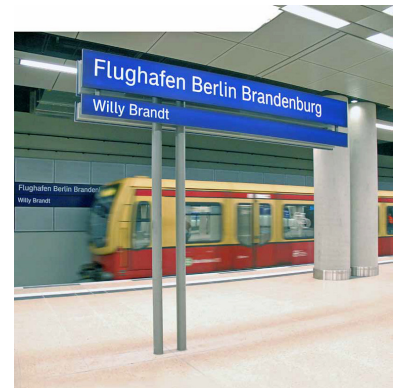
Flughafenbahnhof Berlin-Brandenburg. Obwohl noch nicht für den Fahrgastverkehr eröffnet (weder bahn- noch luftseitig) fahren täglich S-Bahn- und Regional-Züge durch den Tunnel in den Bahnhof - um das neue Bauwerk zu belüften (Foto: Marc Heller, Bearbeitung: Stefan Retzlaff)
