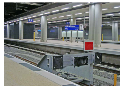
Prellbock am S-Bahn-Gleis im Bahnhof »Flughafen Berlin Brandenburg - Willy Brandt, kurz Bahnhof BER. Im Hintergrund die beiden 400 Meter langen Fern-/Regionalbahnsteige. (Foto: Florian Müller)
