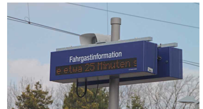
Das Streitobjekt: der Dynamische Schriftdisplay (DSA) mit integrierter Beschallungseinrichtung für Verspätungsanzeigen und -ansagen. (Foto: BfVst)
