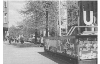
Dieser Treppenabgang am U-Bahnhof Rosenthaler Platz ist inzwischen saniert. (Foto: Irmgard Schmidt, April 1995)
