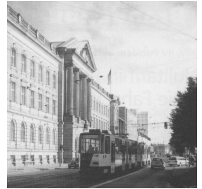
Straße Am Kanal. (Foto: IGEB-Archiv)
