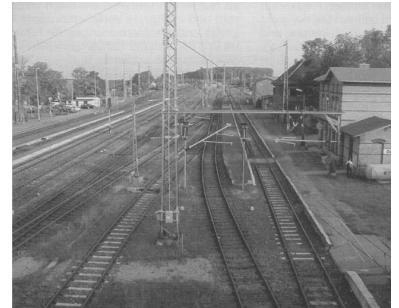
Bahnhof Belzig: Hier am Empfangsgebäude der ehemaligen Städtebahn beginnt die Strecke nach Niemegek. (Foto: Georg Radke)
