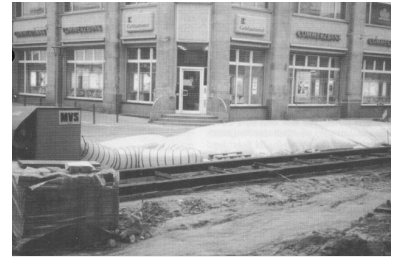
Keine (Heizungs-)Kosten wurden gescheut, damit jahrelang verschleppte Straßenbahn-Eröffnung am Alex trotz starkem Frost doch noch termingerecht im Dezember 1998 stattfinden konnte. Die Baufirmen lehnten schon damals jede Gewährleistung ab, und so dauerte es gerade mal drei Jahre, bis die Gleise auf einigen Abschnitten erneuert werden mussten. (Foto: IGEB-Archiv)
