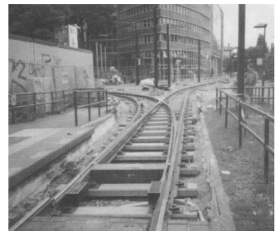
Wie am Alexanderplatz mussten auch am Hackeschen Markt die teilweise sehr engen Gleisradien erneuert werden. Sie waren ebenfalls im Winter gebaut worden. (Foto: Hans Grasse)
