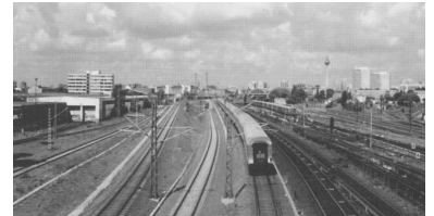
Blick zum Ostbahnhof (Bildmitte). Von den Gleisen der Wriezener Bahn (am Bildrand rechts) muss endlich eine Gleisverbindung zu den Fernbahngleisen (im Vordergrund) hergestellt werden. (Foto: Alexander Frenzel)
