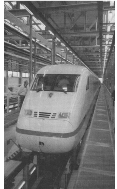
Die Triebzughalle des ICE-Werks Berlin-Rummelsburg mit einem der aufgeständerten Gleise. (Foto: Christian Schultz)
