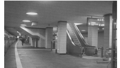
Bahnhof Friedrichstraße, Bahnsteig D, nach der Sanierung. Nicht nur der Bahnsteig wurde entrümpelt, bedauerlicherweise fielen dieser Säuberungsaktion auch notwendige Fahrgastinformationen zum Opfer. (Foto: Florian Müller)
