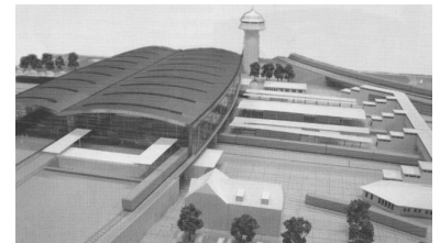
Der neue Bahnhof Ostkreuz nach dem Neubau aus Richtung aus Richtung Norden. In der Bildmitte quer die Bahnsteige von/zur Stadtbahn. Links die neue Ringbahnhalle (große Halle) mit der Regionalbahnhalle (kleine Halle). Die Straßenbahn hält direkt am Bahnhof. (Modell: DB Projektbau, Foto: Florian Müller)
