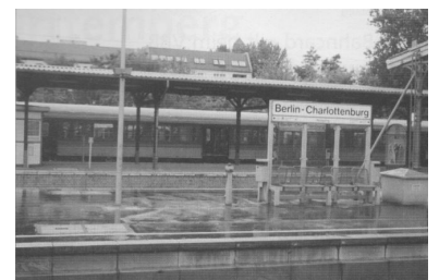
Der Bahnhof Charlottenburg wird während der Sperrung der Stadtbahn in Richtung Bahnhof Zoo der westlichste Endpunkt der S-Bahn werden. Dafür halten hier zusätzliche Regionalexpress-Linien. (Foto: Frank Böhnke)
