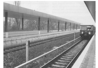
Der seit Jahren ungenutzte Regionalbahnsteig in Jungfernhöhe wird zum Fahrplanwechsel endlich in Betrieb genommen. Hier besteht guter Anschluss zum Nordring und zur U-Bahn. (Foto: Florian Müller, November 2002)
