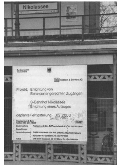
Auch auf den Baustellenschildern entlang der Wannseebahn waren die Aufzüge für Februar 2003 angekündigt worden, doch die Fertigstellung ist auch zwei Monate später auch nicht absehbar. (Foto: Alexander Frenzel, 25. März 2003)
