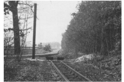
Bereits wenige Tage nach dem letzten Zug war das Straßenbahn-Gleis abgebaut und als Radweg asphaltiert. Wenn das Bauen von Straßenbahnstrecken doch auch so schnell ginge... (Foto: Florian Müller, 28.2.2003)
