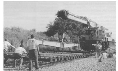
Einbau eines Gleisjoches. (Foto: DB AG, Jazbec)
