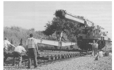
Einbau eines Gleisjoches. (Foto: DB AG, Jazbec)
