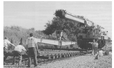
Einbau eines Gleisjoches. (Foto: DB AG, Jazbec)
