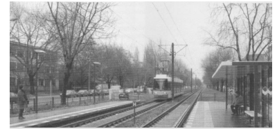
Seit 13 Jahren die einzig wirklich neue Straßenbahn-Strecke in Berlin: vom S-Bahnhof Bornholmer Straße zum Virchow-Klinikum. (Foto: Marc Heller)
