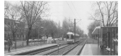
Seit 13 Jahren die einzig wirklich neue Straßenbahn-Strecke in Berlin: vom S-Bahnhof Bornholmer Straße zum Virchow-Klinikum. (Foto: Marc Heller)
