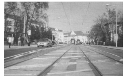
Man sieht nur wenig auf den ersten Blick, und das ist auch der Vorteil dieser Haltestellenform. Statt bei Platznot für eine separate Haltestelleninsel auf eine Station ganz zu verzichten, oder aber trotz Niederflurbahnen von der Straße aus eine Stufe überwinden zu müssen, wird einfach die Fahrbahn angehoben. Sie wird damit während des Tramstops zu einer zweitweisen Haltestelleninsel. (Foto: Arthur Frenzel)
